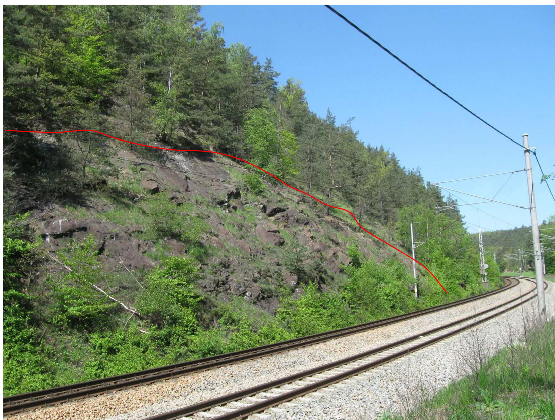
Obr.2 Skalní svah (odkryv) v km 13,620 pohled směr Kuřim, celkový pohled. Červenou čarou je označena nevýrazná hrana svahu odřezu, výše je svah v mírnějším původním sklonu.
