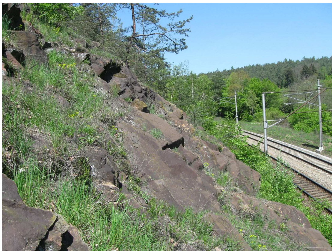
Obr.4 Skalní svah pohled dolů na trať, sklon svahu cca 45°.
