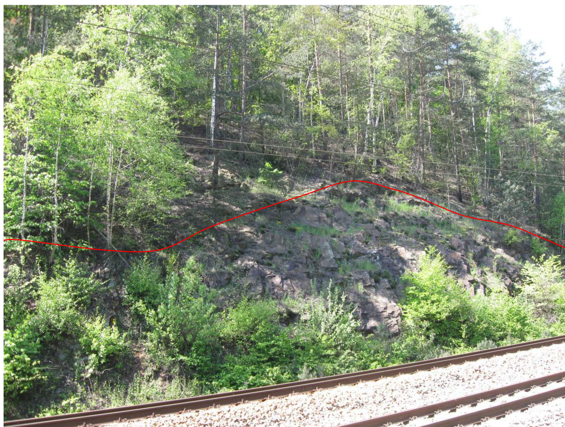
Obr. 8 Skalní odřez v km 13,800-13,850, čelní pohled. Červenou čarou je označena horní hrana svahu odřezu, výše je přirozený svah v mírnějším sklonu s drobnými výchozy.
