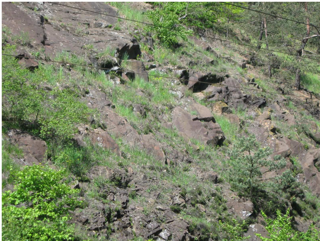
Obr.3 Skalní svah (odkryv) v km 13,650 detail, ve spodní části hustěji rozpukané granodiority
