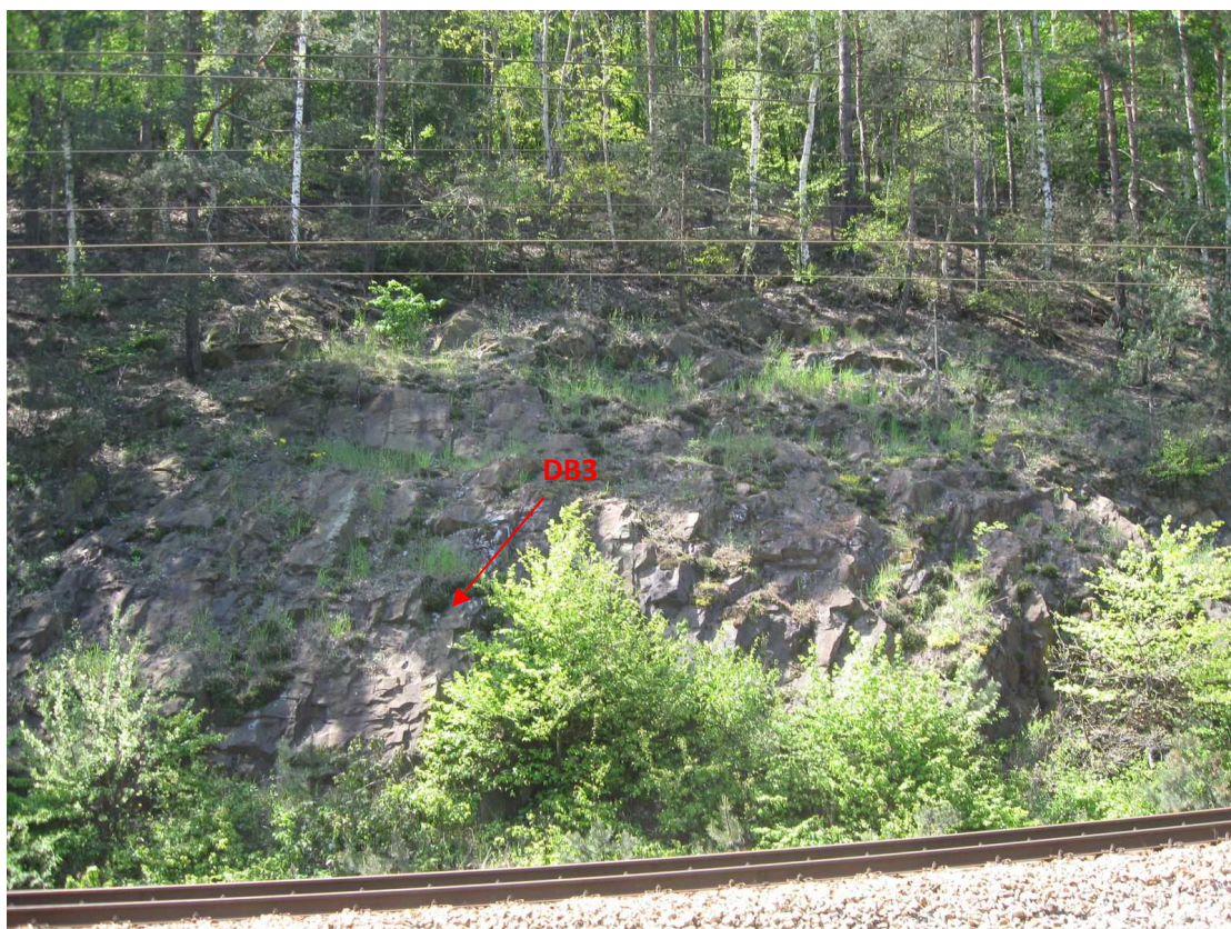
Obr. 9 Skalní odřez o výšce 5-6 m v km 13,810-13,840, detail čelního pohledu s místem dokumentačního bodu DB3
